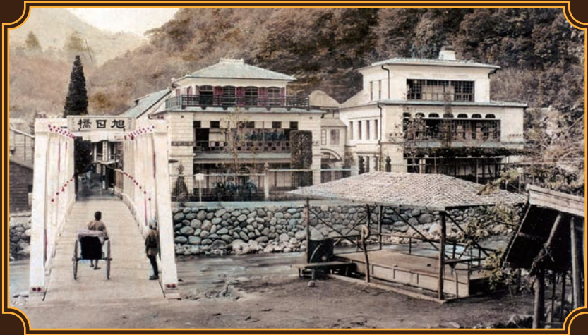
福住旅館 金泉樓・萬翠樓
